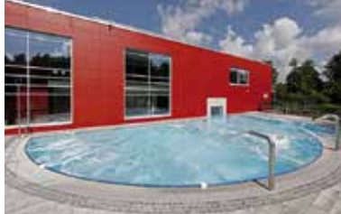
Hallenbad Ost, Soleaußenbecken
